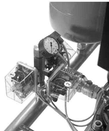
**Fig. 22** Interruptores de presión en el colector
